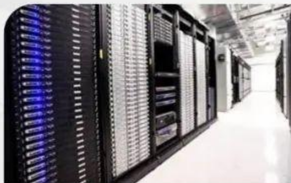
机房建设工程
